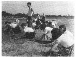
生徒の勤労奉仕によるグラウンド整地作業
